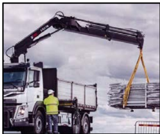
通常クレーン作業(多関節)
