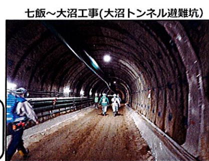
七飯～大沼工事(大沼トンネル避難坑)
